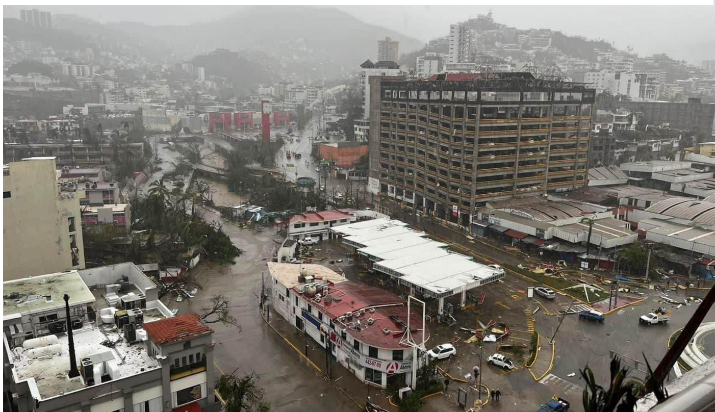
Daños en México por paso huracán
