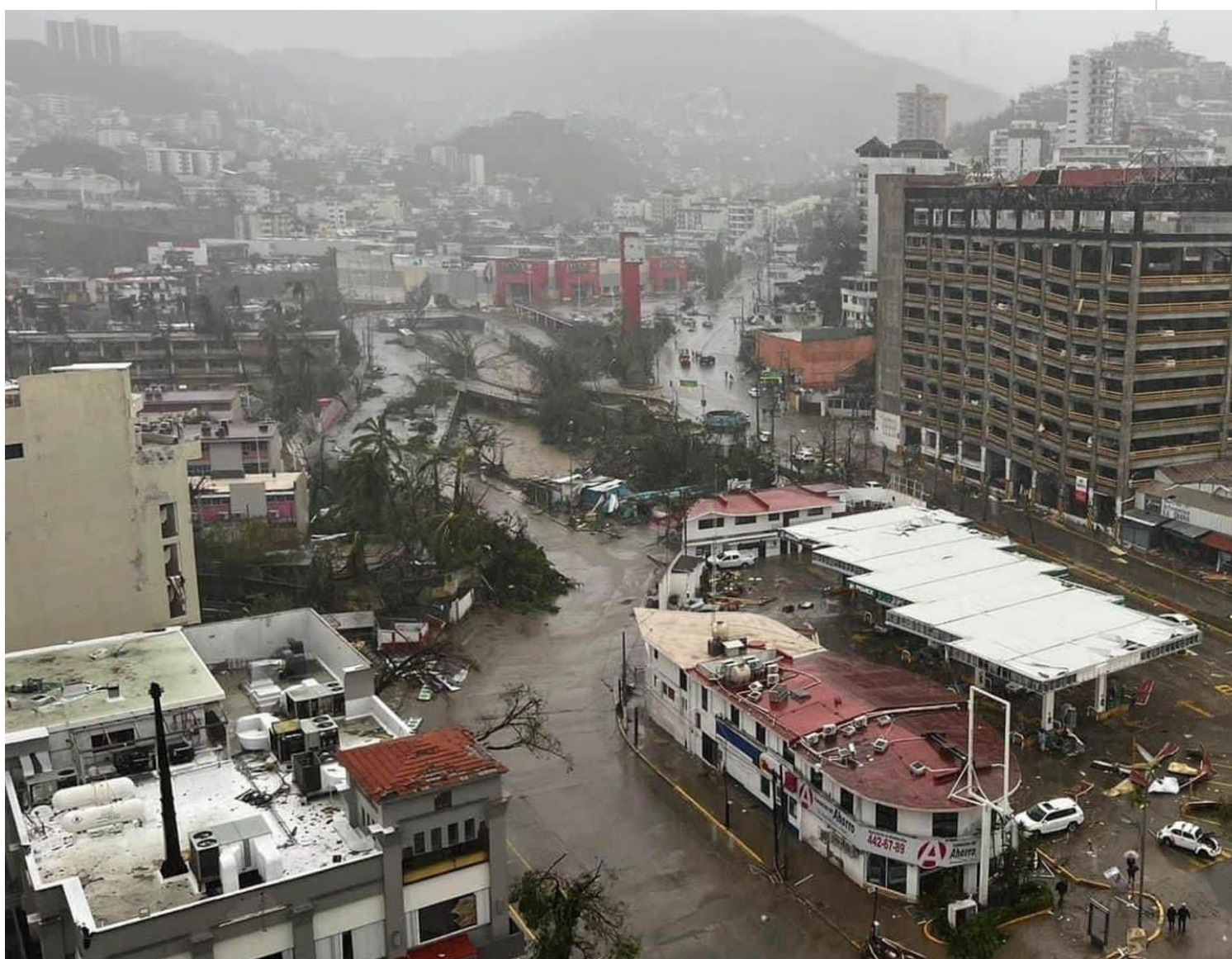
Danos no México, passagem furacão Otis
