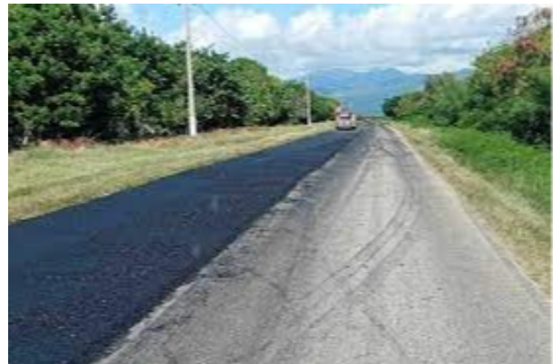
Pavimentación del pedraplen
