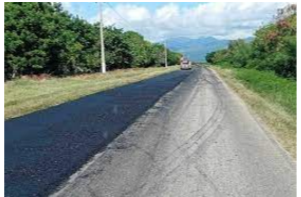
Pavimentación del pedraplen
