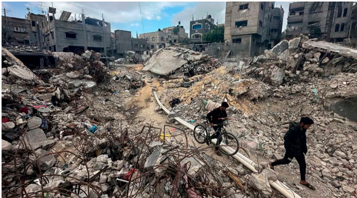
Palestinos caminan entre los escombros, mientras inspeccionan casas destruidas en los ataques israelíes durante el conflicto, en medio de la tregua temporal entre Hamás e Israel, en el campo de refugiados de Khan Younis. Foto: Reuters.
