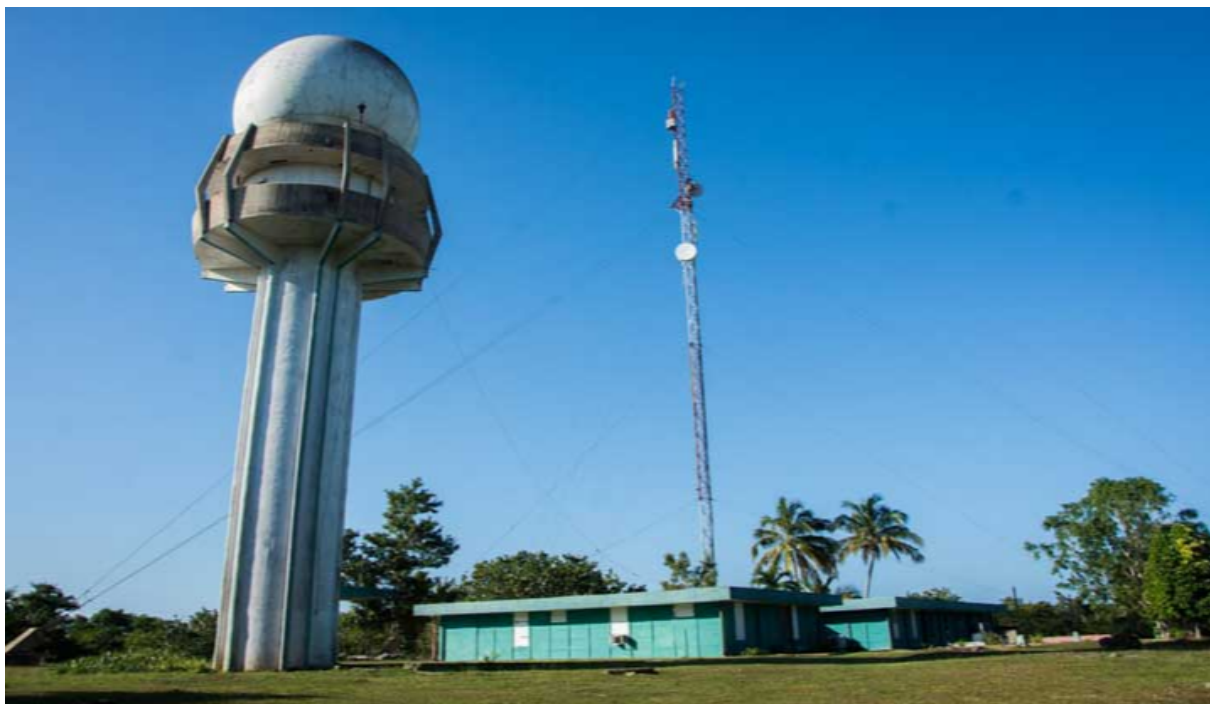
El Radar de La Bajada
