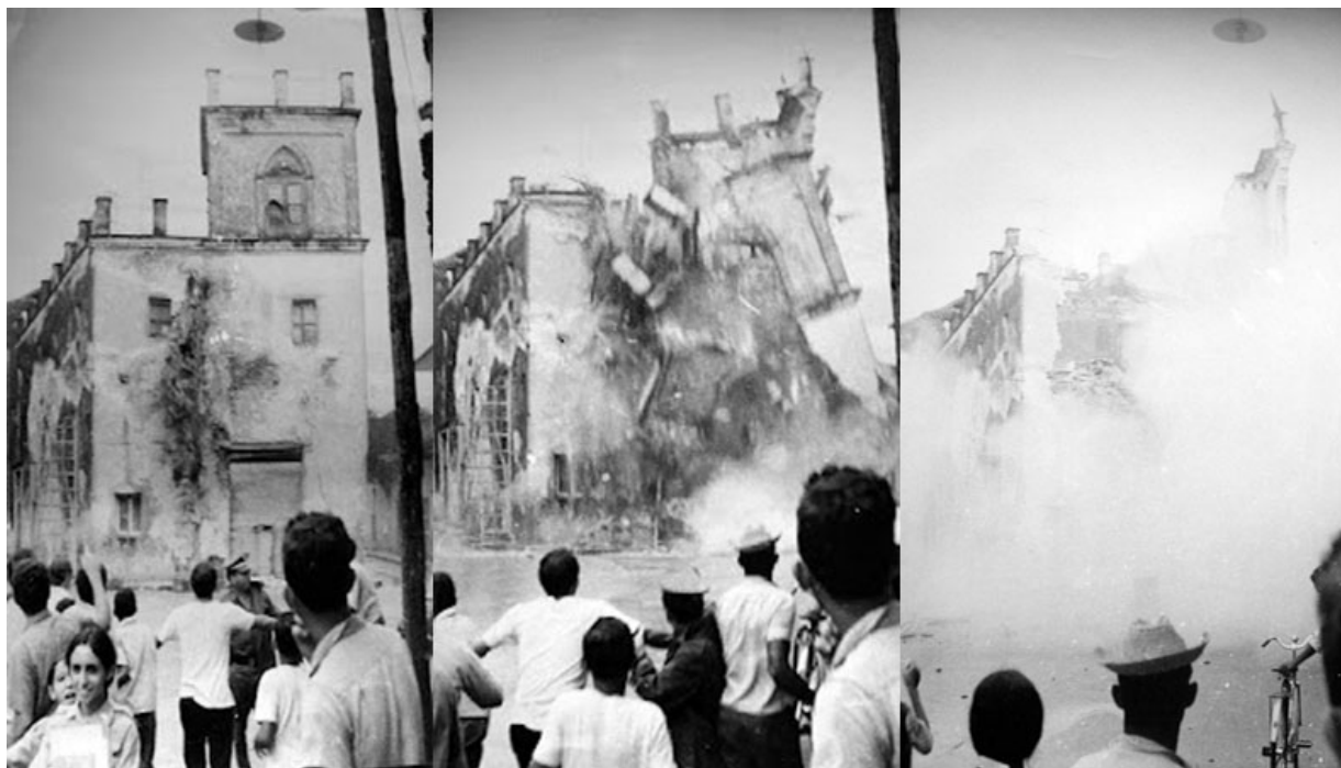
Derrumbe de la ermita
