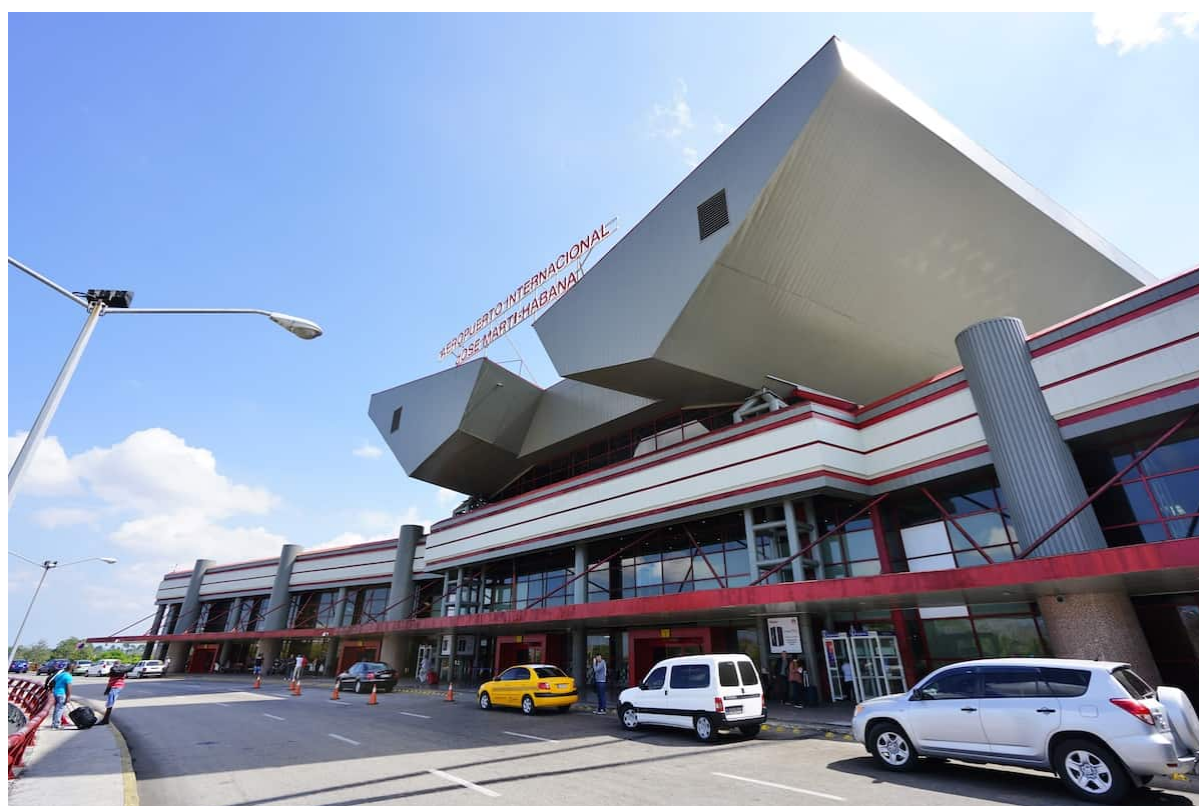
Terminal 3 del aeropuerto internacional José Martí. Foto: Havana Airport
