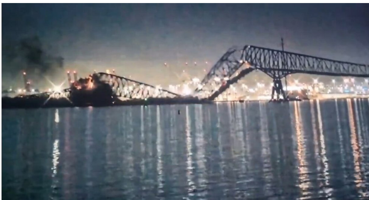
Colapsa puente en Baltimore al colisionar un buque carguero
