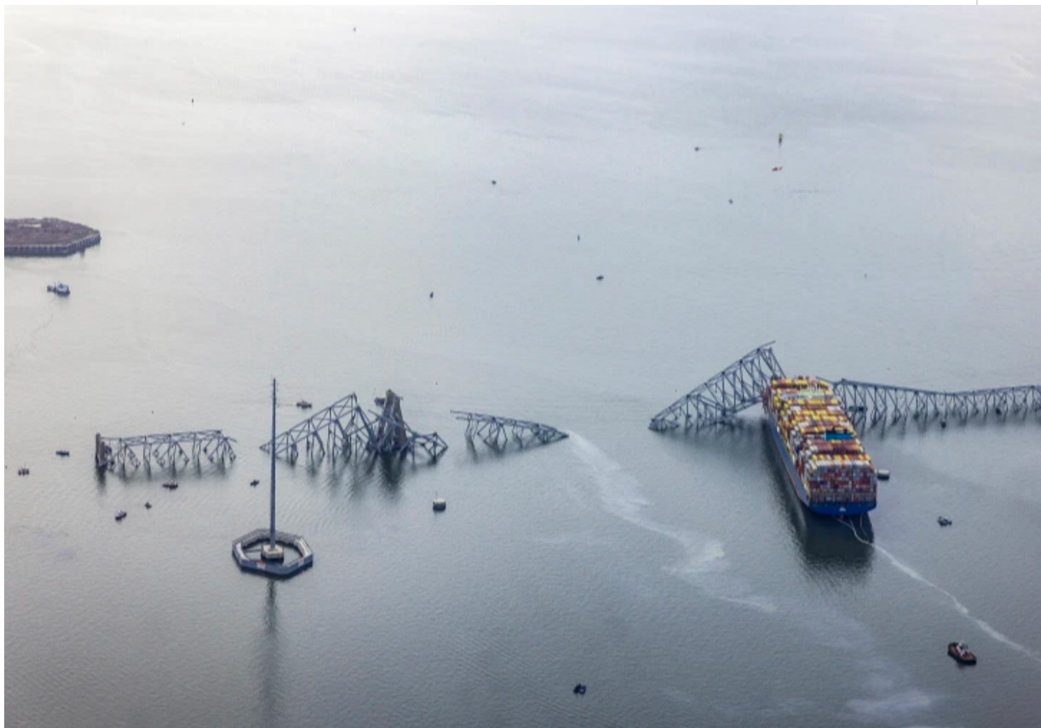
Colapso del puente de la ciudad estadounidense de Baltimore.
