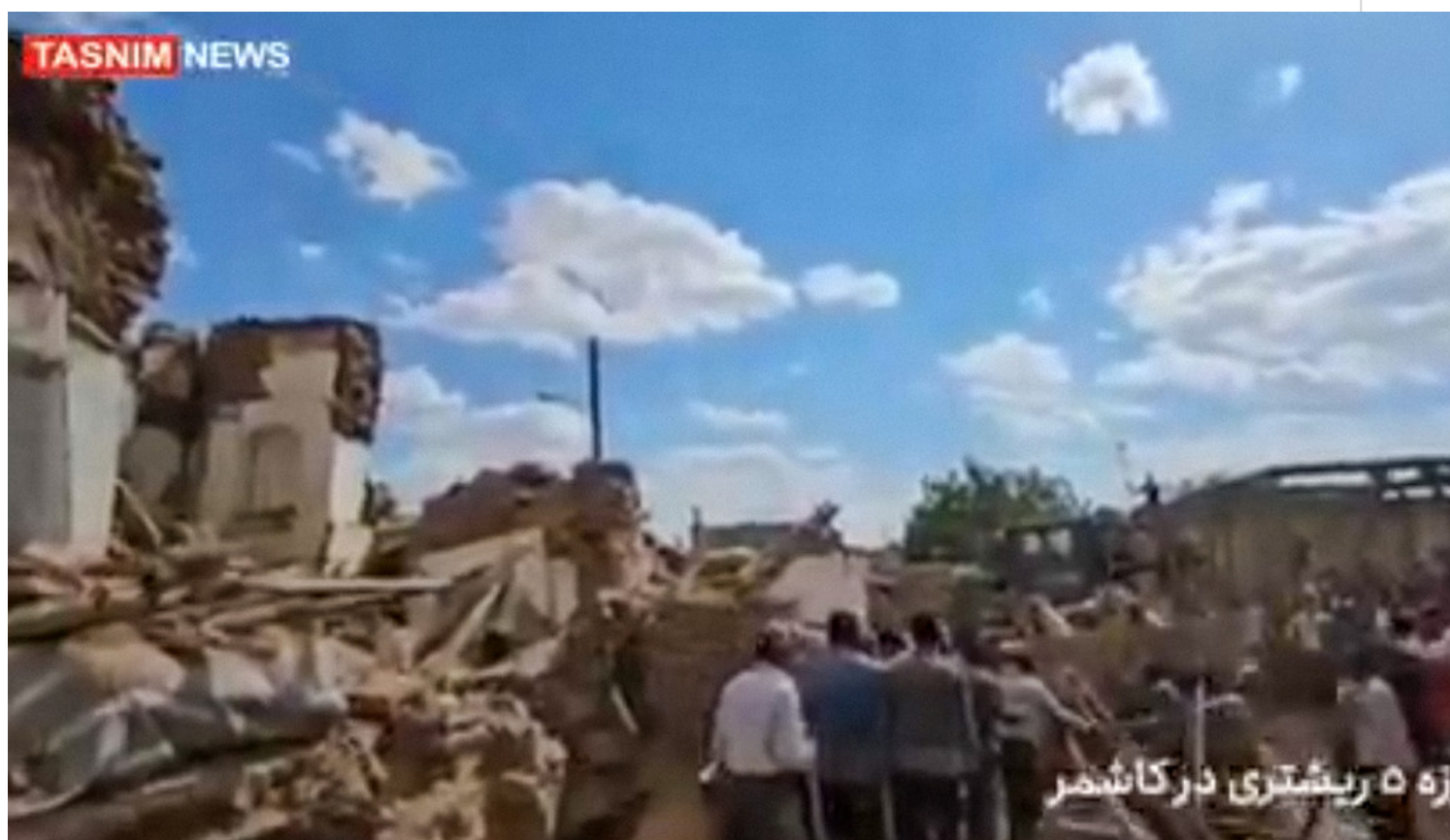
Terremoto en Irán. Foto: RT
