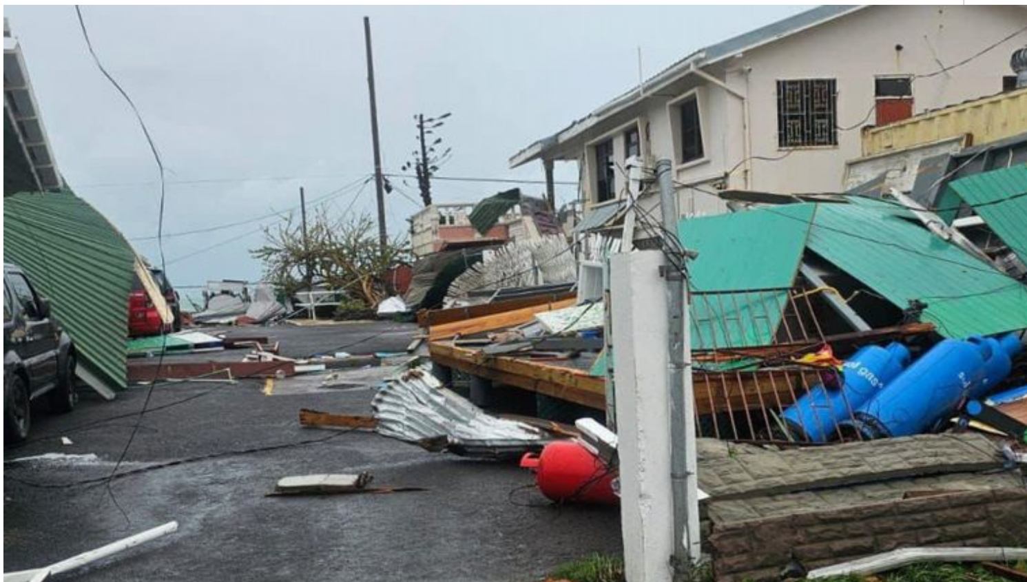
Destrozos ocasionados por el huracán Beryl.
