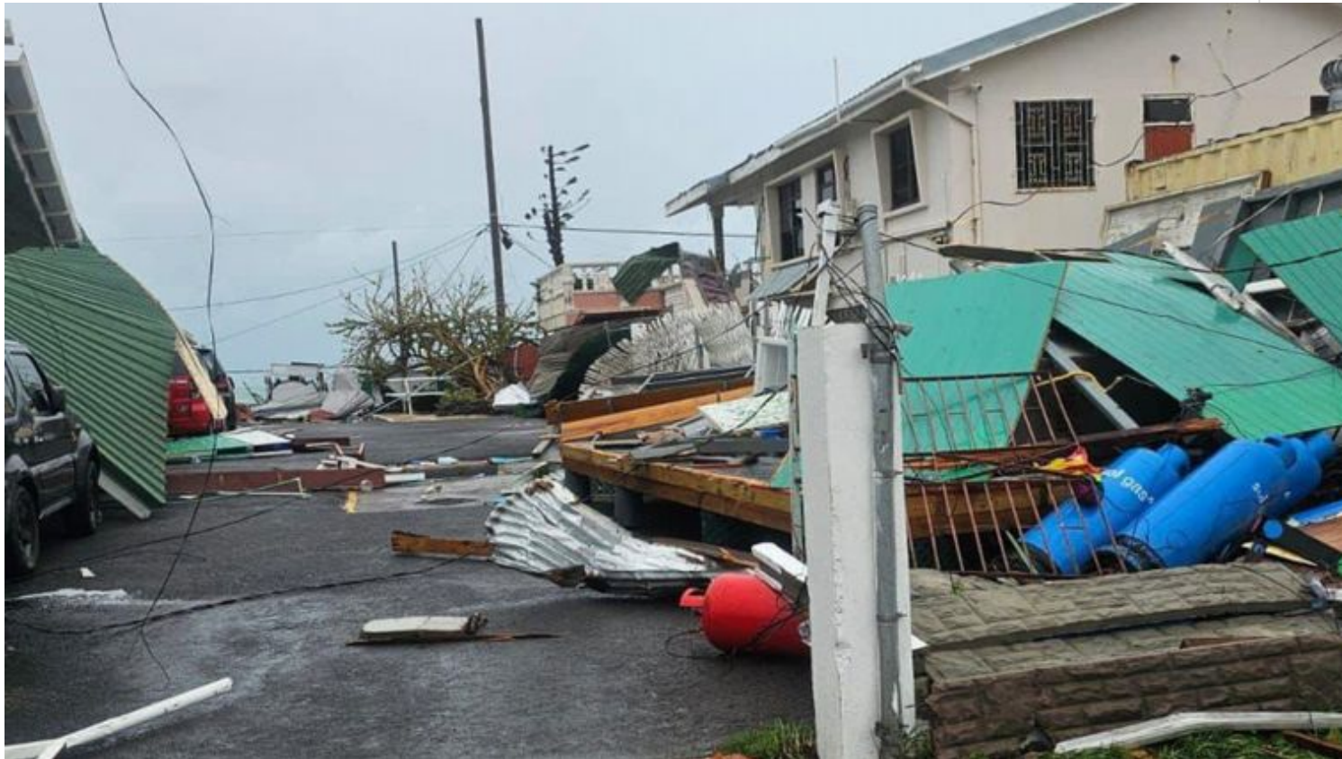
Destrozos ocasionados por el huracán Beryl.
