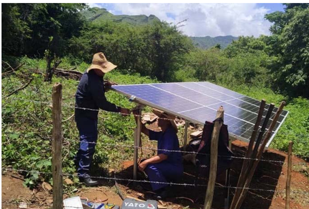
Instalan paneles solares en región montañosa de Cienfuegos. Imagen:ACN
