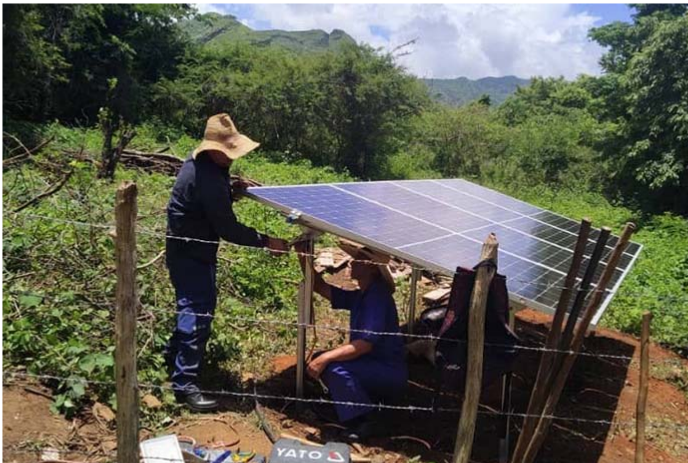
Instalam painéis solares na região montanhosa de Cienfuegos
