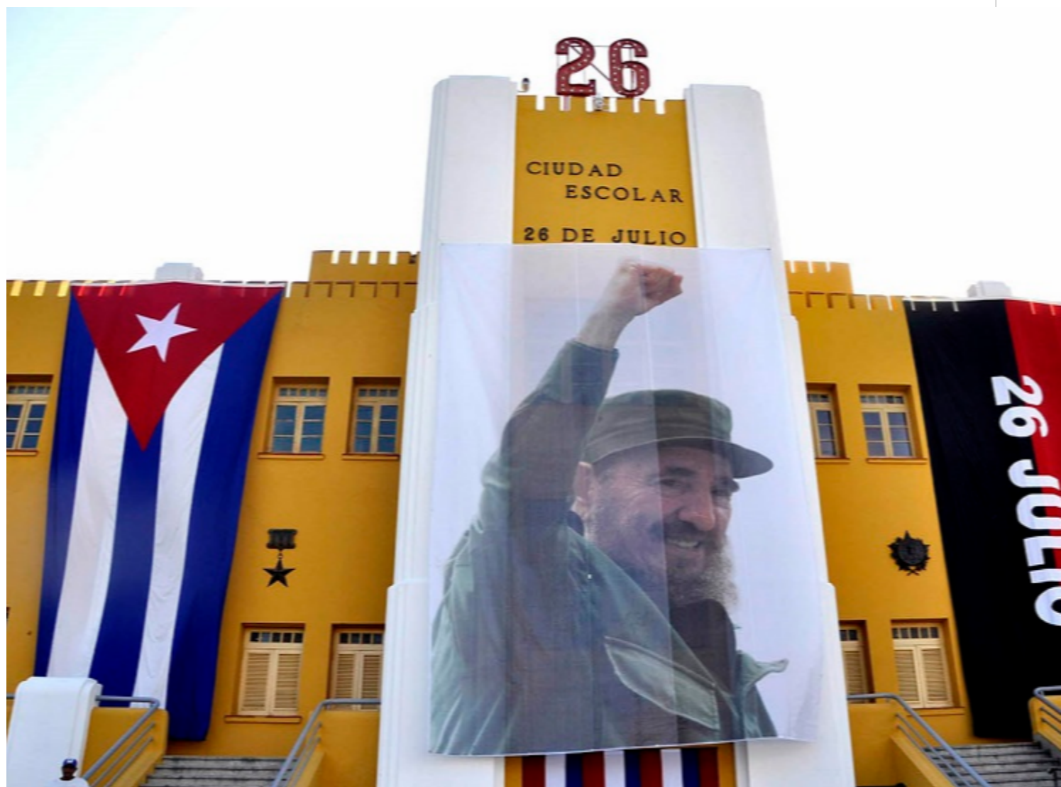
Ancienne Caserne Moncada aujourd'hui Cité Scolaire 26 juillet
