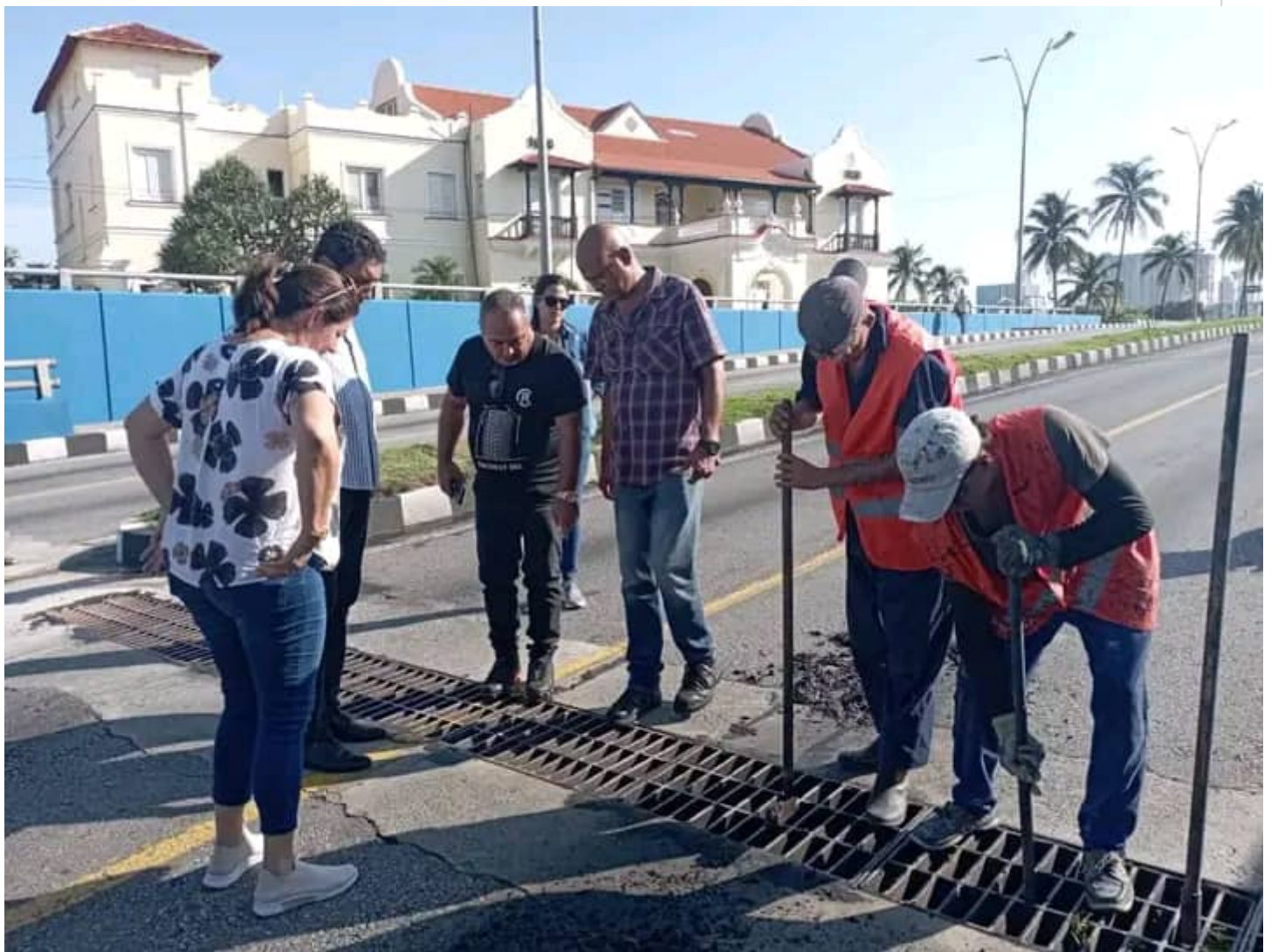
Obras en el túnel de Quinta Avenida.
