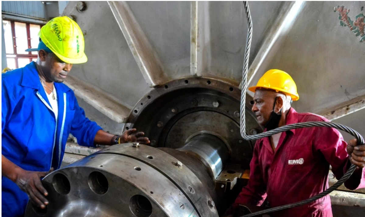
Reparaciones en la CTE de Felton. Foto: Juan Pablo Carreras/Archivo-ACN
