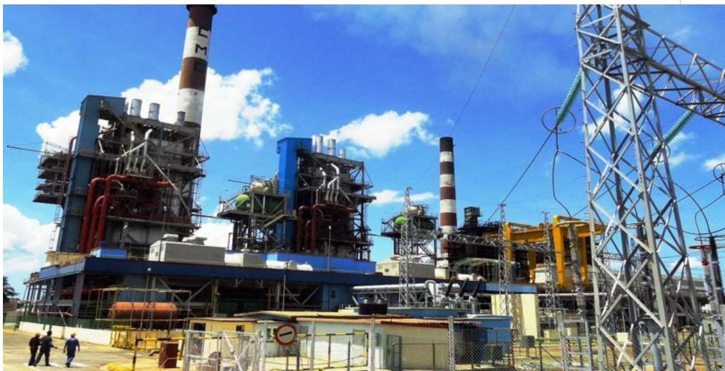
Central Termoeléctrica Carlos Manuel de Céspedes. (Imagen de archivo/RHC)
