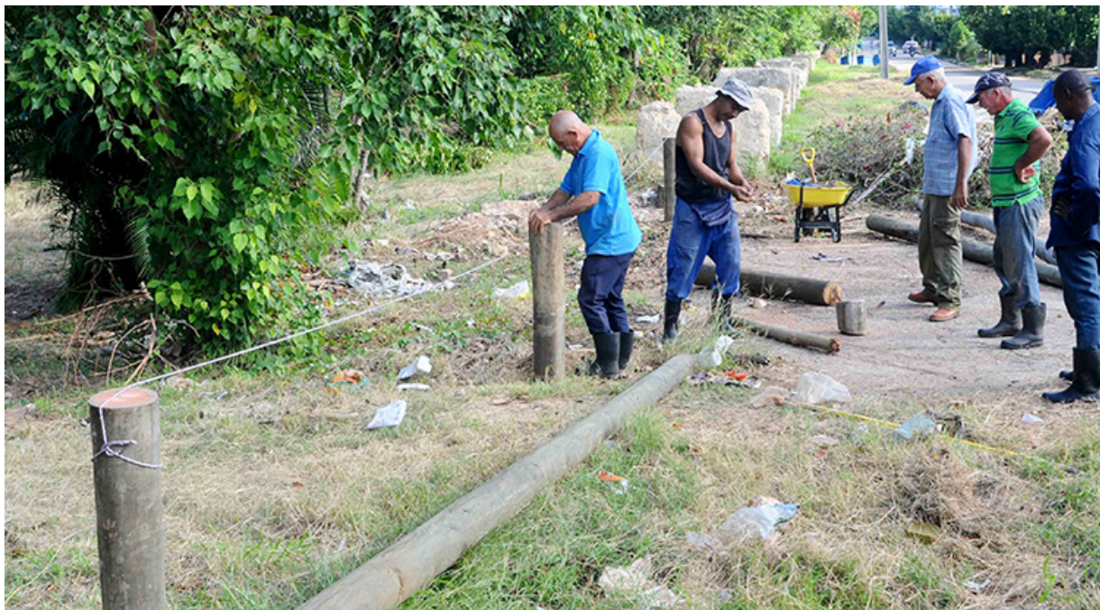
Proceso de rehabilitación. Foto: Marcelino Vázquez Hernández
