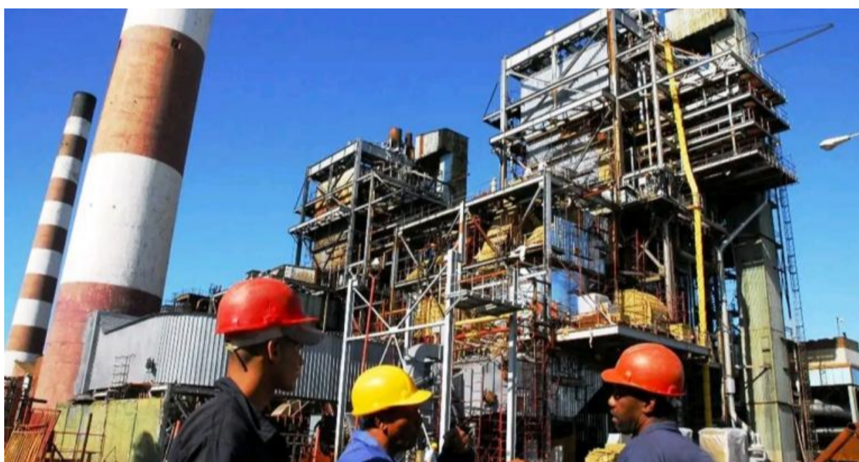
Miguel Díaz-Canel, encomió hoy la labor de los trabajadores del sector eléctrico
