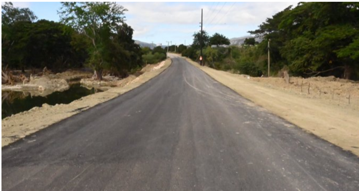
Reconstrucción del vial en el puente de Acopio
