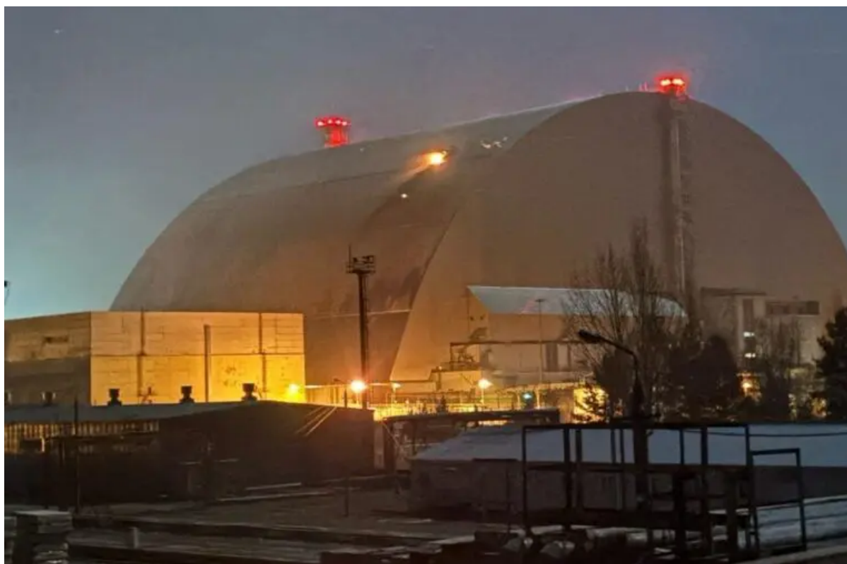
Un dron atacó el escudo protector de un reactor nuclear que se encuentra dañado en la central de Chernóbil. Foto: @iaeaorg
