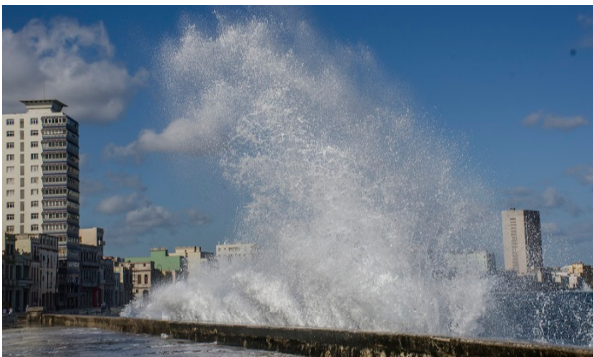
El fuerte oleaje sobrepasa el muro. Foto: Archivo/Excelencias Cuba
